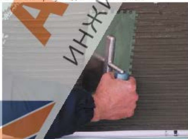
Рис. Нанесение клея на стену
