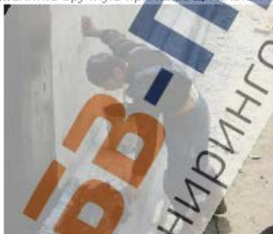
Рис. Обмазка фундамента мастикой вручную кистью
