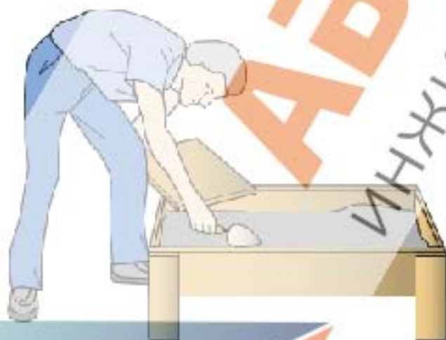
Набрасывание раствора на сокол
